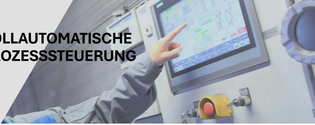
Die PMT-Anlagensteuerung ermöglicht die zentrale, vollautomatische Prozessführung über HMI-Panel und SPS-System. Die Rohstoffaufnahme wird lastabhängig über die Rotorstromaufnahme als Maß für die Beladungsdichte im Mahlraum geregelt und verhindert Überladung und stabilisiert den Top-Cut für konstante Endkorngrößen. Optional integrieren wir Remote-Zugriff sowie lückenlose Datenerfassung aller Kernparameter zur Echtzeit-Überwachung, Trendanalyse und sicheren Reproduzierbarkeit.
